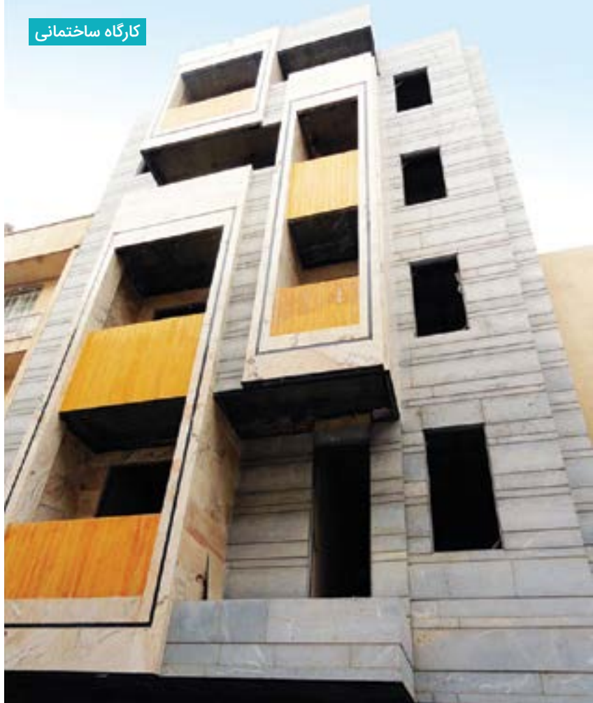
نمای ساختمان از داخل حیاط
